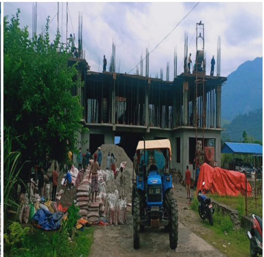
निर्माणधिन अवस्थाको प्रशासनिक भवन
