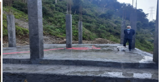
निर्माणाधिन ढकालटार समाज भवन
