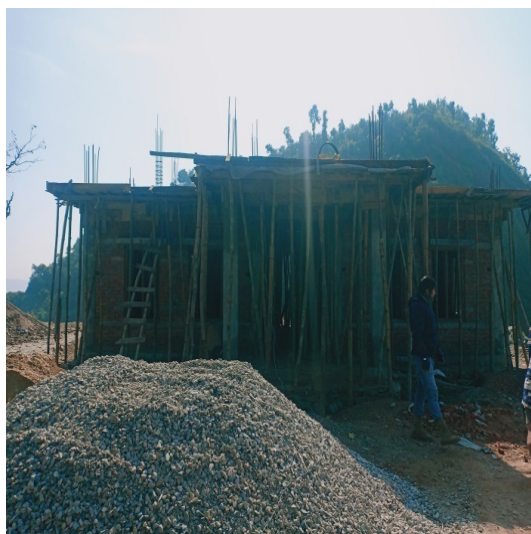
निर्माणाधिनको अवस्था ५ नं. वडा कार्यालय
