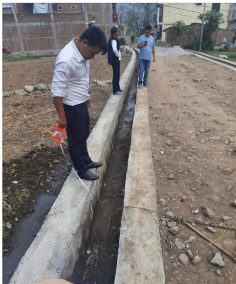
एकता टोल नाला निर्माण
