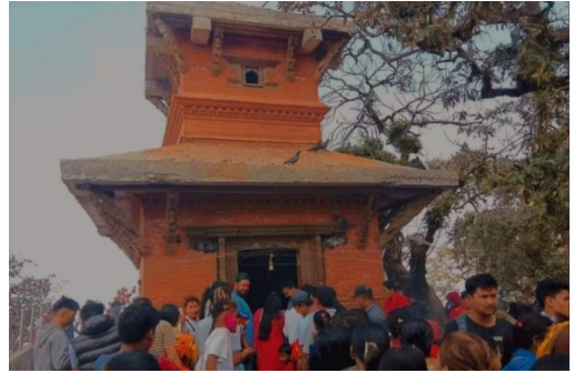
वडा नं. ५ मा रहेको निर्माणाधिन छिम्केश्वरी मन्दिर
