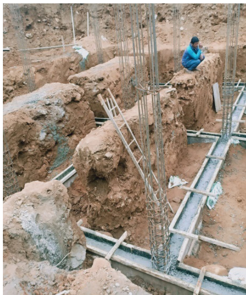
निर्माणाधिनको अवस्था ४ नं. वडा कार्यालय
