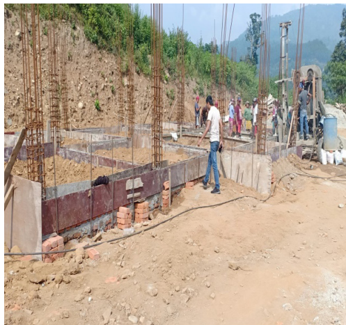
निर्माणाधिनको अवस्था १ नं. वडा कार्यालय
