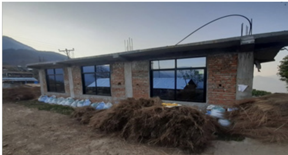
कोट गाउँ सामुदायिक भवन
