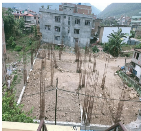
निर्माणाधिन वहुउद्देशीय भवन
