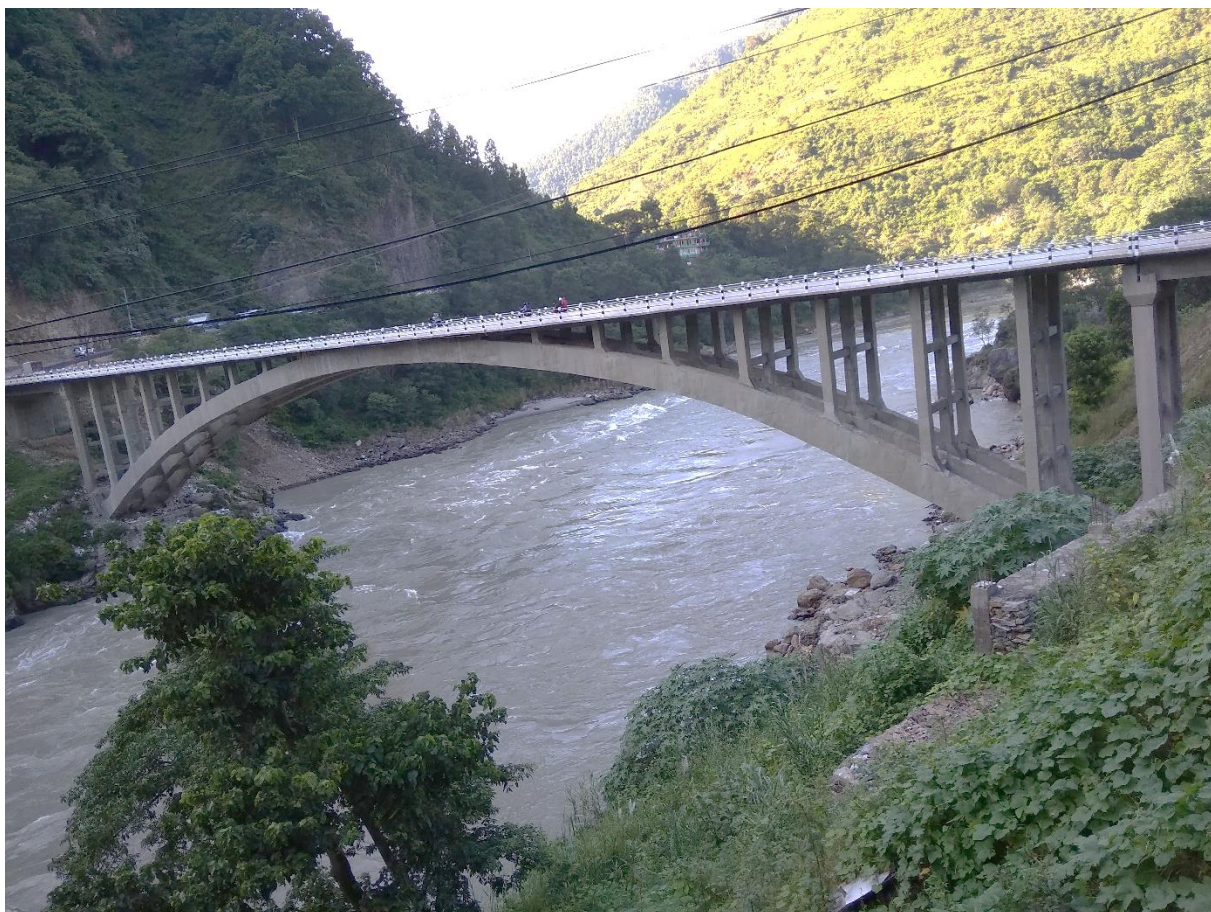
मुग्लिन र आँबुखैरेनी-४ जोड्ने नवनिर्मित पक्की पुल
